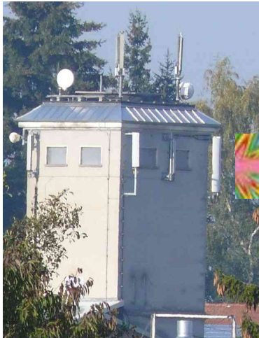
Mobilfunkstandort mit 10 Sektorantennen (längliche Kästen) und Richtfunksendern (Schüsseln)
